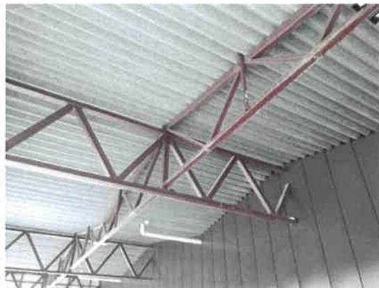
Katoksen kantavana rakenteena teräsristikot ja pilarit
