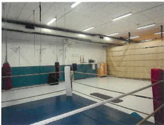
Kellarikerroksen Sali, jossa on tehty kosteusvaurion jälkeen korjaustoimenpiteitä
