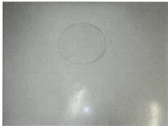
Kaivonkansi salin lattiassa tiivistetty
