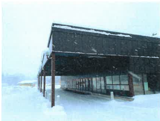
Pääsisääkäynnin kohdalla oleva katos
