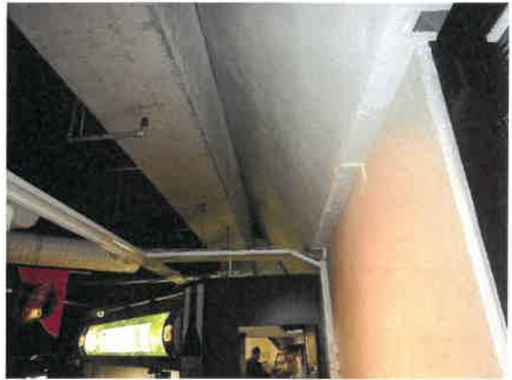
Julkisivuelementin liitos runkoon
