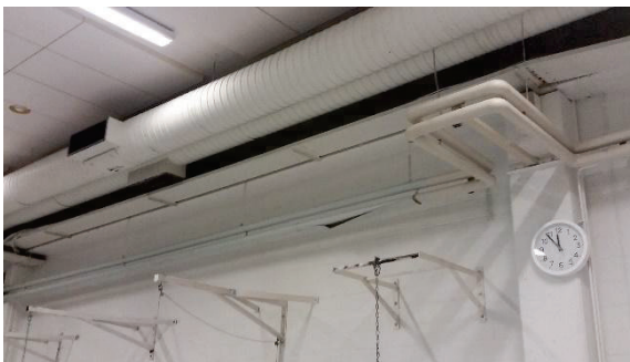
Putkilaajennus nyrkkeilytilan katossa
