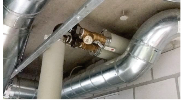
Sulku- ja linjasäätöventtiili
