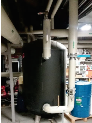
Varaajasäiliö teknisessä tilassa
