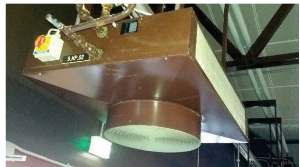
Sisäänkäynnin kiertoilmapuhallin
