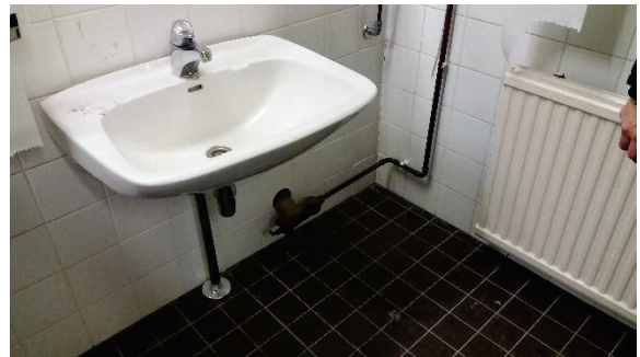
Vesijohto ulkokentän kioskille
