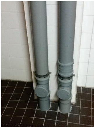
Puhdistusluukut viemäriin alapäässä
