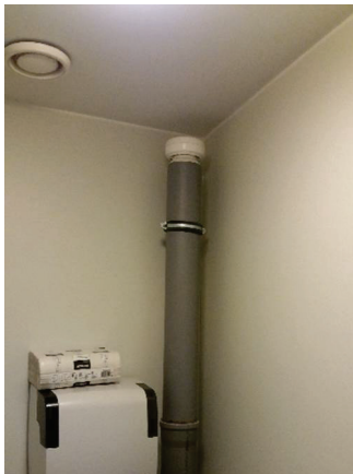
Alipaineventtiili keittiön WC-tilassa
