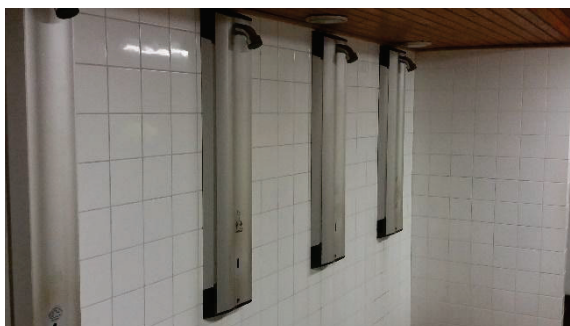
Pukuhuoneiden elektroniset suihkusekoittajat
