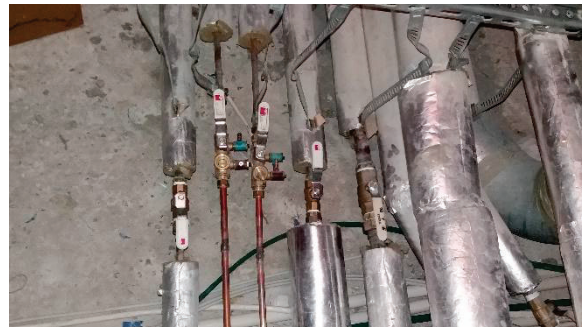
Sulkuventtiilit putkitilassa
