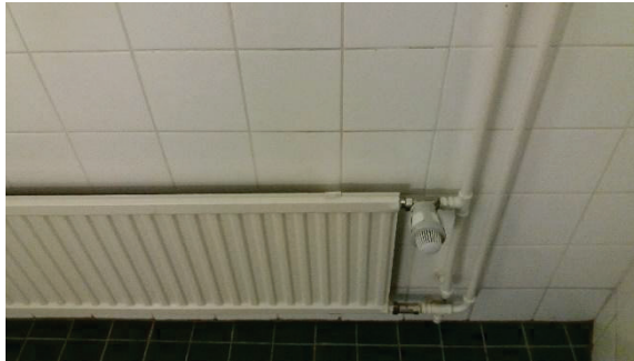
Vanha patteri ja Kovec-termostaatti
