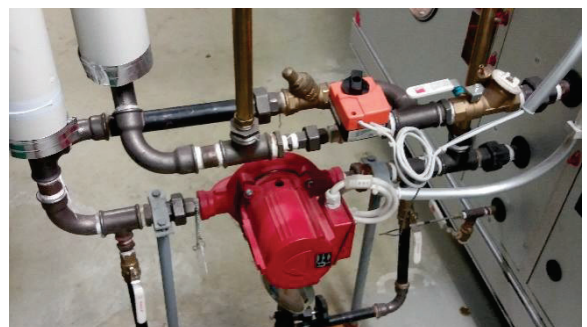
IV-koneen lämmityspumppu
