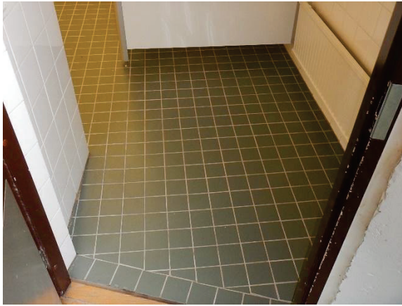
Uusittua märkätilan lattialaattaa
