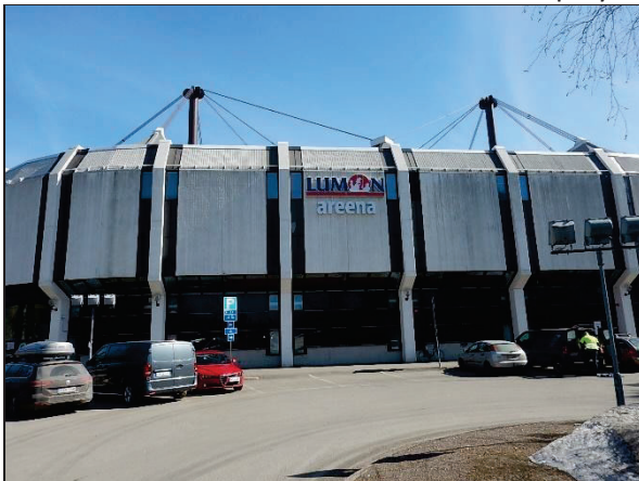
Yleiskuva lännenpuoleisesta julkisivusta
