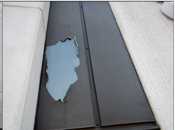
paikallista peltiosien pinnoituksen hilseilyä
