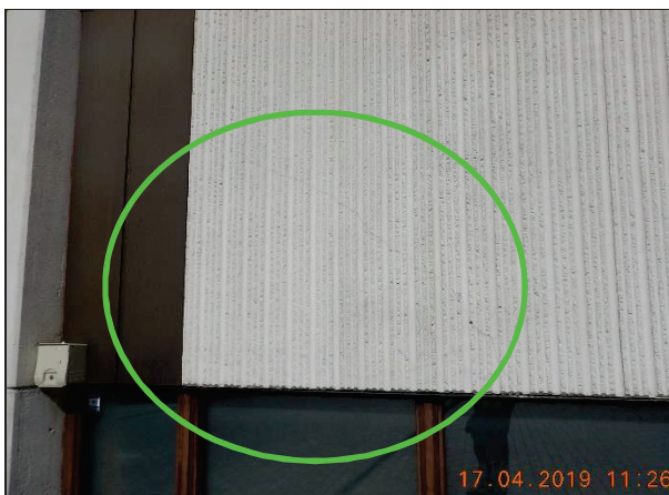
paikallista vinottaista halkeilua
