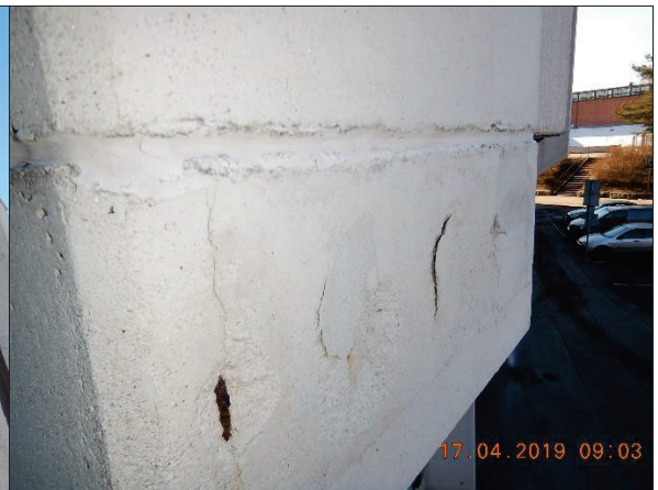
Pilareiden kuorielementissä raudoitukseen yltävää paikallista lohkeilua
