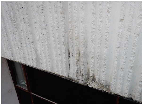
paikallista paikkakorjauksen lohkeilua
