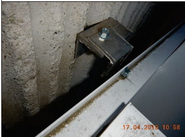
mainoskytlin ruuvikiinnike keskiosalta poikki
