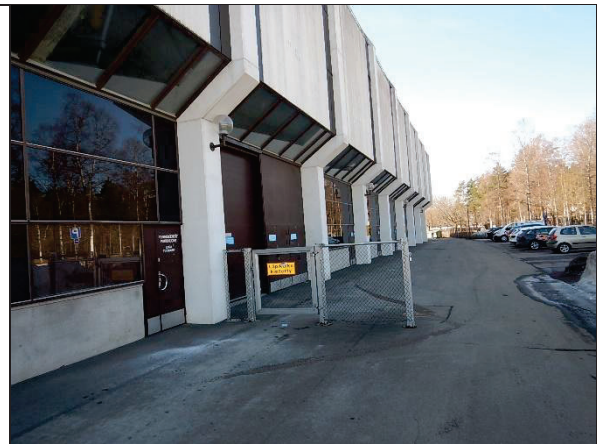
Yleiskuva pohjoispuolen julkisivusta
