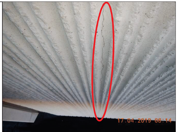
Elementtien korkeuden mittaisia pystyhalkeamia
