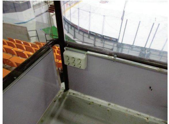
Katsomossa harvinaisia 6-osaisia pistorasioita
