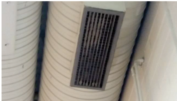
Voimailutilan poistoilmäsäleikkö
