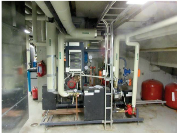
Kaukolämmön vaihdinpaketti
