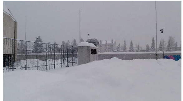
Ulkoilmasäleikkö tupakkapaikan lähellä
