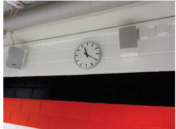
Järjestelmään kytketty sivukello käytävän seinällä
