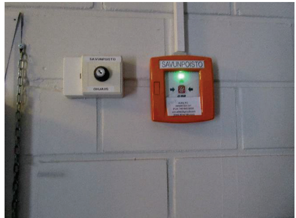
Savunpoiston laukaisupainike ja ohjauskytkin
