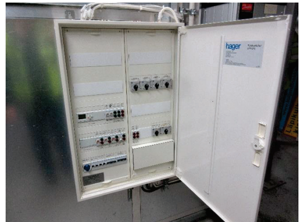
LTO-laitteen sähkökeskus
