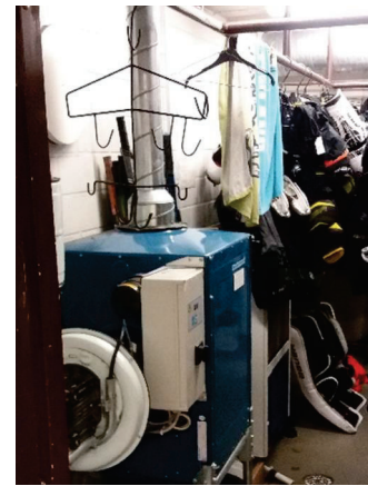
Luistimen teroituspisteen poistopuhallin
