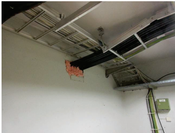
Palouretaanin käyttöä muuntajan kaapeloinnin läpivienneissä
