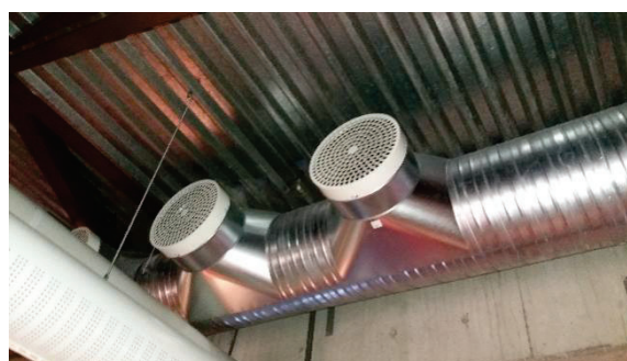
Ravintolan poistoilmaventtiilit
