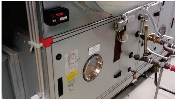
Tuloilmapuhaltimen tarkastusikkuna
