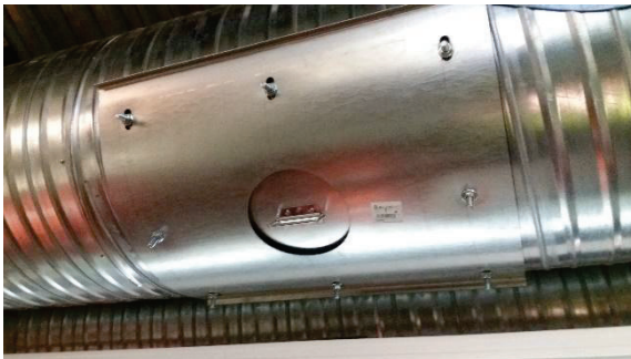
Tarkastusluukku IV-kanavassa
