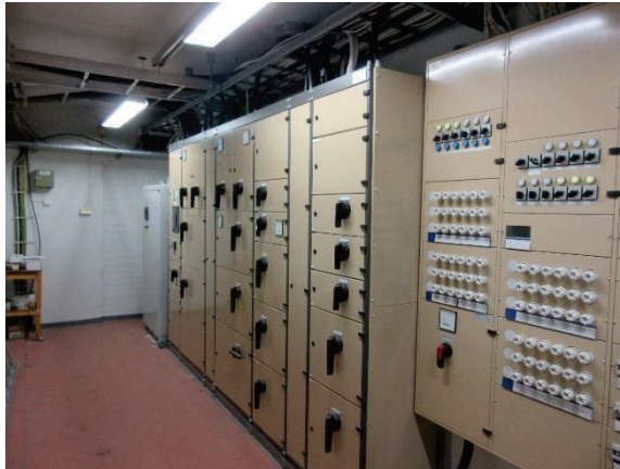
Kiinteistön sähköpääkeskus
