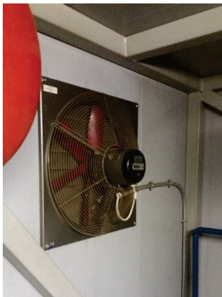
Kompressoritilan yllämpöpuhallin
