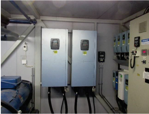
Jäähdytyskonekkojen isoja taajuusmuuttajia
