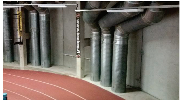
Kanavien nousut kaukalon yläpuolelle
