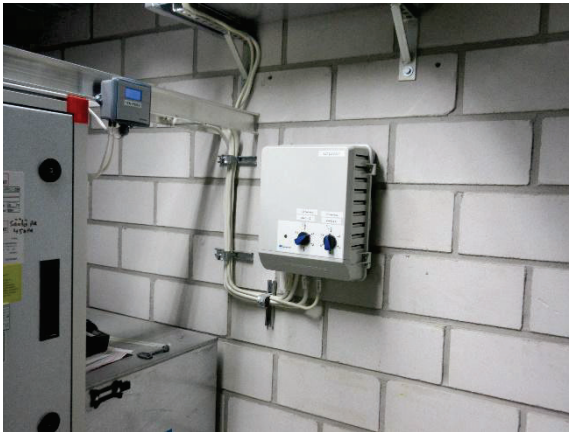
Ilmanvaihtokoneen erillissäädin
