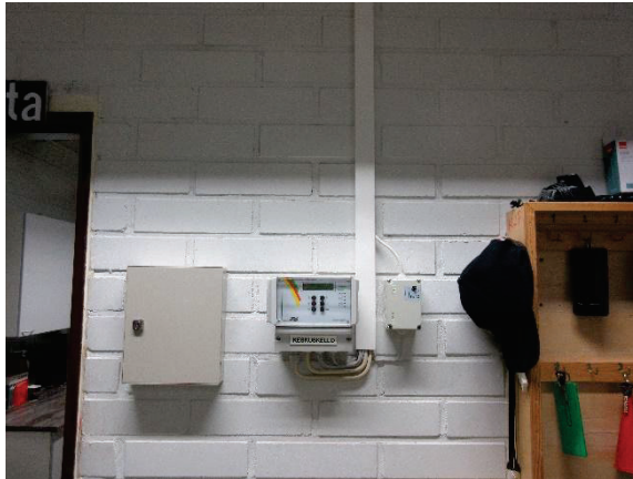
Ajannäyttöjärjestelmän pääkello ja tahdistin vahtimestarin huoneessa
