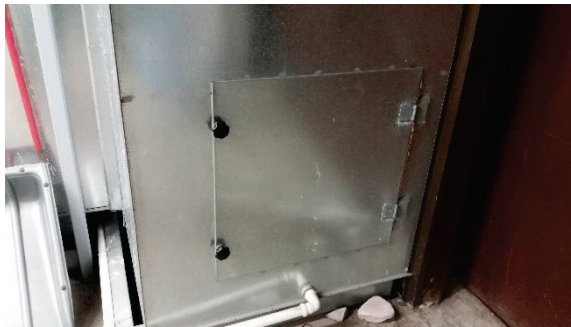
Ulkoilmakammion tarkastusluukku
