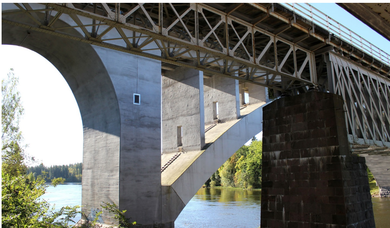
Kuva 28. Korian sillat, edustalla vanhempi teräksinen silta ja takana uudempi betonisilta.
