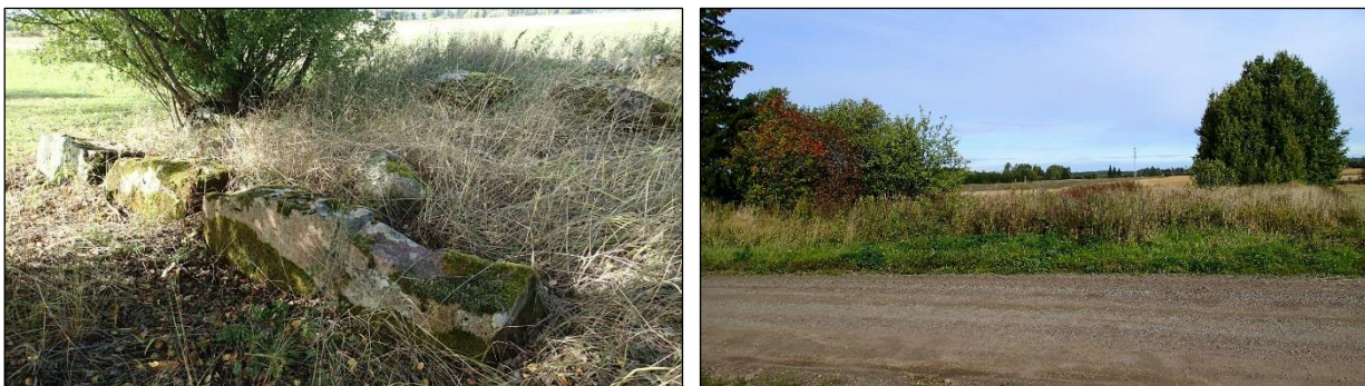
Mikkolan talon rakennuksen perustuksen jäännös, rakennus purettu 1930-luvulla Alakylässä. Alakylän aluetta.
