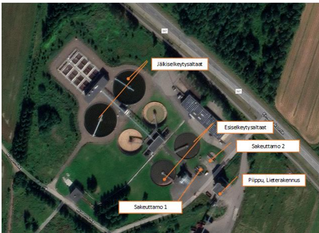
Kuva 1. Mittauskohteet jäteveden puhdistamolla.
