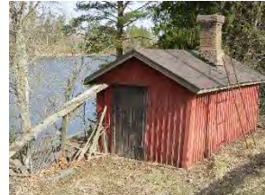
Kuva 218. Jokisillantie 719, saunarakennus, rak.vuosi?
