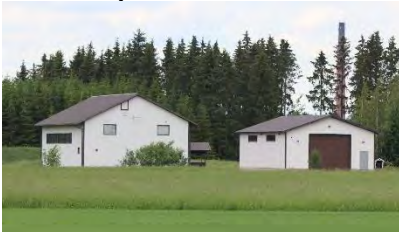
Kuva 286. Törmäsuora 5, talusrakennukset ovat valmistuneet v. 2003 ja 2006.
