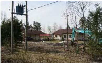
Kuva 214. Jokisillantie 788, v. 2006. Taustalla Jokisillantie 786, v. 1991.
