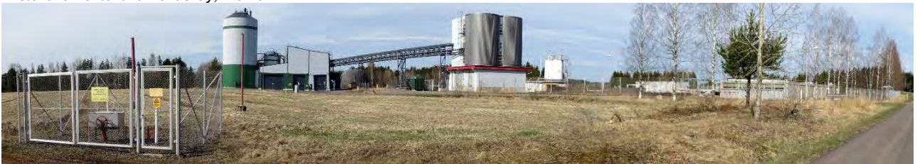
Kuva 129. Kouvolan Vesi Oy:n jätevedenpuhdistamo (v. 1976) ja biokaasulaitos (v. 2014) on erotettu Jukon tilasta.
