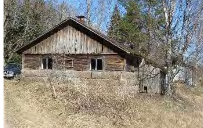
Kuva 207. Aholan navettarakennus (v.?) sijoittuu kiinni Huhdanniementiehen.
