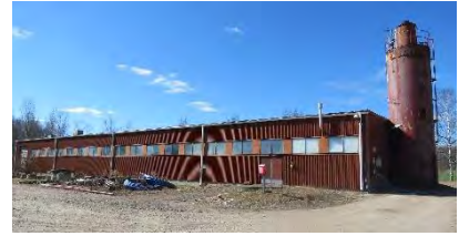
Kuva 205. Huhdanniementie 194, jätevedenpuhdistamo, v. 1976.
