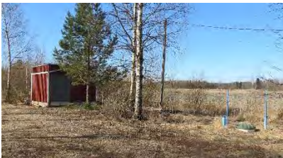
Kuva 341. Peltoalueen keskellä sijaitsee viemäriverkoston pumppaamorakennus.
