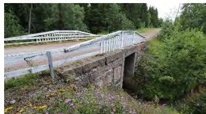
Kuva 108. Sarkojan ylittävä silta.
