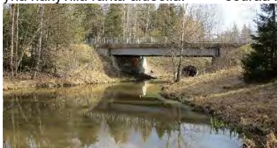
Kuva 147. Vanha teräspalkkinen maantiesilta 367. Taustalla uusi putkisilta.
