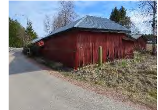
Kuva 219. Jokisillantie 719, talousrakennus rak.vuosi?.
