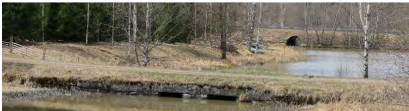
Kuva 280. Tuomiojan yliettä useita siltoja. Kuvassa vanhin kivilta, taustalla Rantatien vanhan tielinjauksen teräksinen putkisilta (sillat sijoittuvat kaava-alueen ulkopuolelle).
