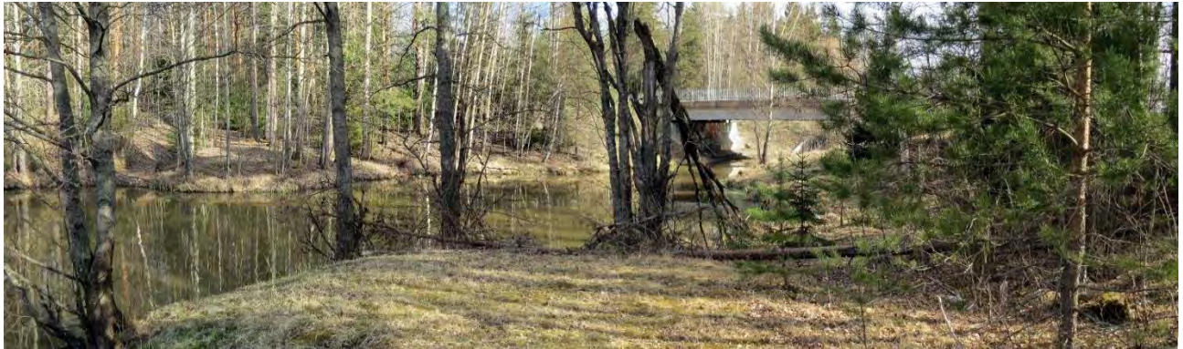
Kuva 142. Näkymä Myllypuron vanhan sillan kohdalta Jukonhovin, eli Kouvola kartanon länsipuolella. Kuvassa taustalla näkyy Kymenlaakson tien (maantie nro 367) vanha maantiesilta, joka on nykyisin kevyen liikenteen käytössä.
