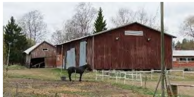
Kuva 242. Anjalantie 2049b talousrakennukset.
