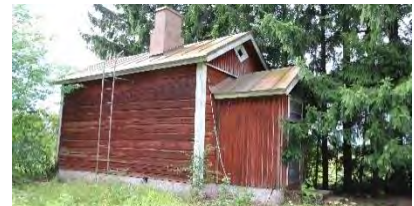
Kuva 49. Alakylän koulun talusrakennukset 1932.
