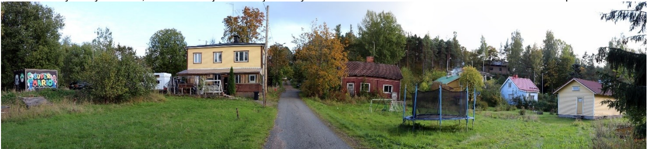
Kuva 20. Näkymä Raidekujalta suunnittelualueen keskeltä. Alueella on useita rakentamattomia tontteja.
