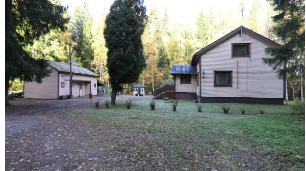
Kuva 17. Näkymä Kulmatien pohjoispäästä.
