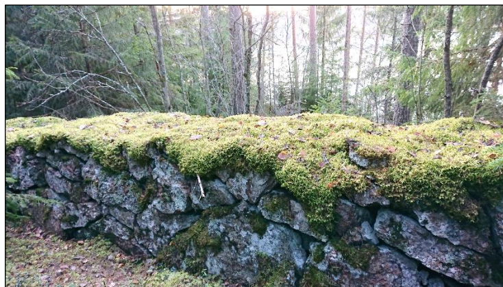
Ladottua muuria/aitaa rinteessä. Pohjoiseen. Luoteeseen.
