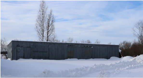
Kuva 8. Alakyläntie 7 piha-alueen varistorakennus v. 1982.
