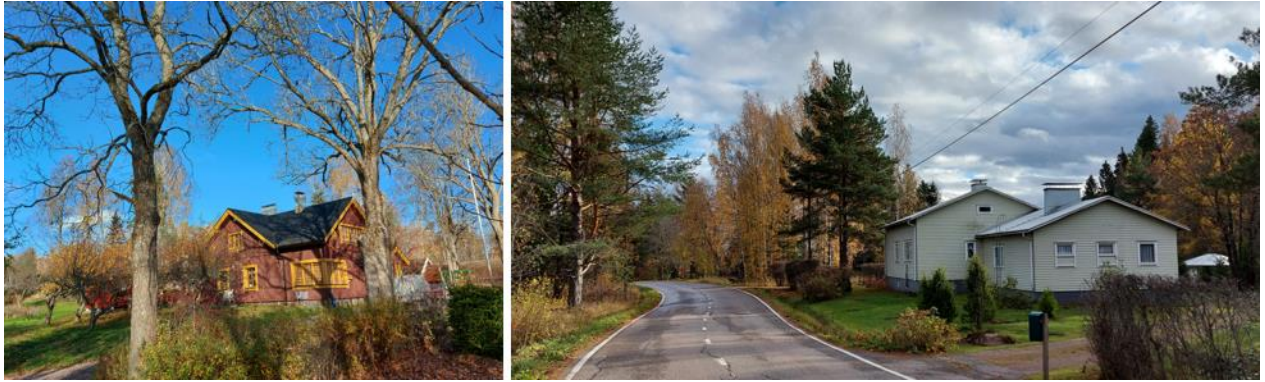
Kuva 8. Rakennuksia Huhdanniementien varrella.
