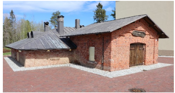
Kuva 6. Kellarirakennus on rakennettu 1910-luvulla.
