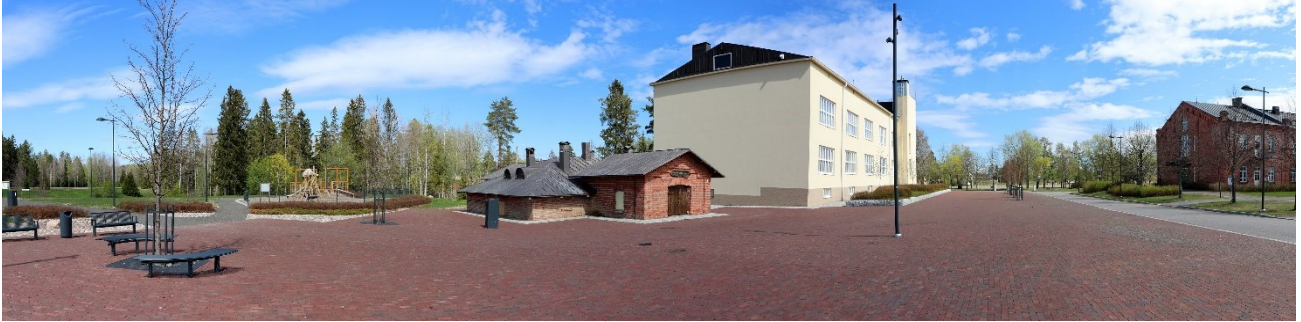
Kuva 4. Näkymä Kouluaukiolta kohti Pioneerikoulua ja sen vieressä sijaitsevaa kellarirakennusta toukokuussa 2022.
