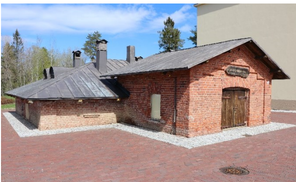
Kuva 11. Kellarirakennus Kouluaukion suunnalta tarkasteltuna.
