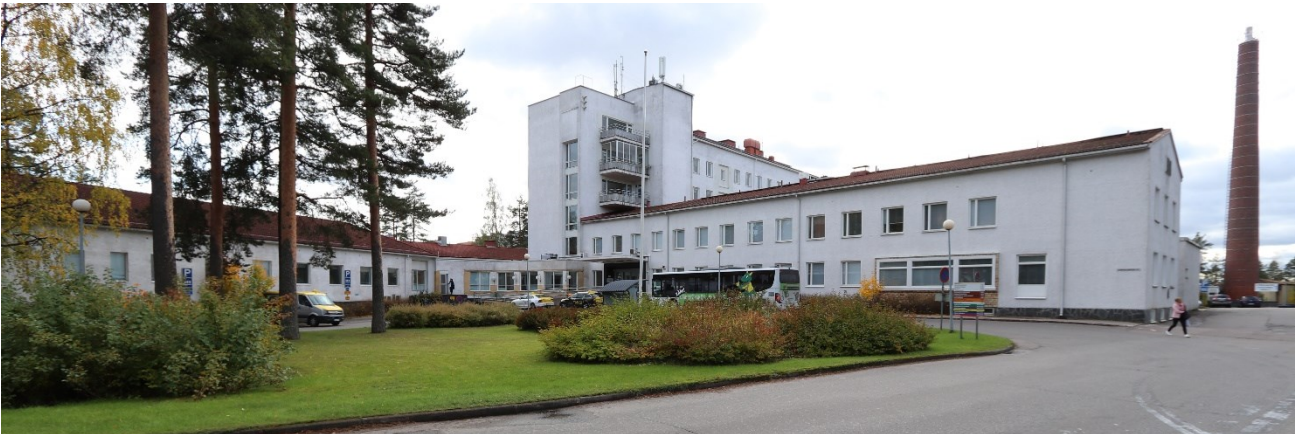
Kuva 3. Vanha sairaalarakennus on rakentunut useammassa vaiheessa. Kuvan rakennukset edustavat rakennuksen ensimmäistä vaihetta, jonka on suunnitellut arkkitehti Ragnar Wessman 1953. Sairaala on laajennettu vuosina 1966, 1982, 1983 ja 1989.
