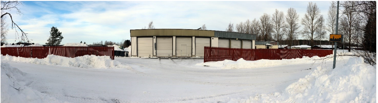
Kuva 2. Näkymä suunnittelualueelle etelästä kaava-alueeseen kuuluvalta Lauttarannantieltä. Kuvassa vasemmalla oleva aidattu alue sijoittuu asemakaavan merkityn korttelin 8053 alueen ulkopuolelle.
