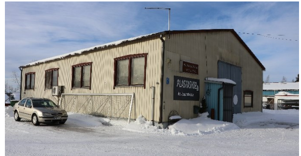
Kuva 8. Alakyläntie 9, valmistunut vuonna 1979.
