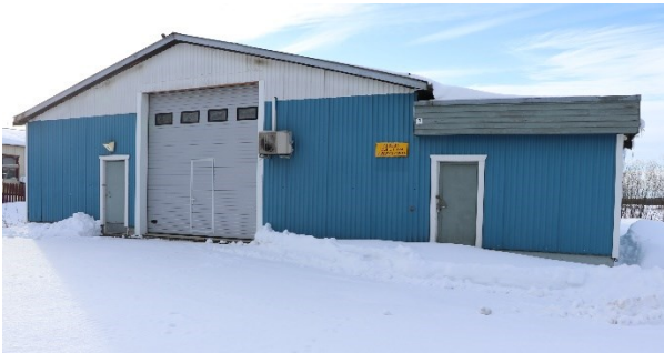
Kuva 6. Alakyläntie 7 valmistunut vuonna 1974.
