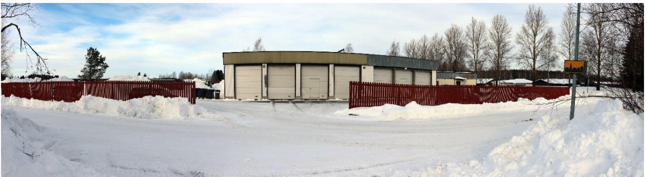
Kuva 3. Näkymä suunnittelualueelle etelästä kaava-alueeseen kuuluvalta Lauttarannantieltä. Kuvassa vasemmalla oleva aidattu alue sijoittuu asemakaavan mukaisen korttelin 8053 ulkopuolella olevalle vuokra-alueelle. Alue on kaavassa vaara-alueita.
