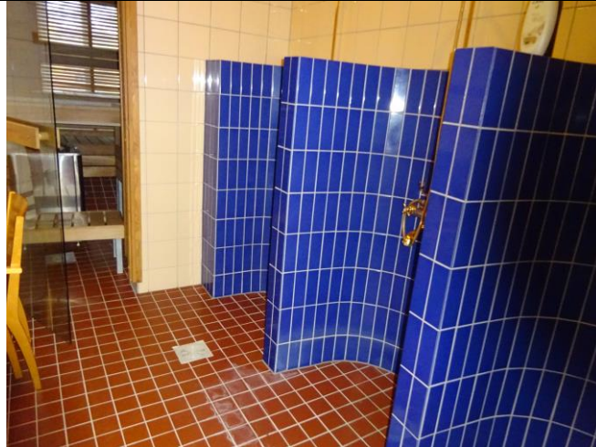
Kuva 10, yleiskuva suihkujen kohdalta.
