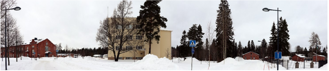
Kuva 3. Näkymä Airon tien ja Väinö Väinön tien risteysalueelta kohti Pioneerikoulua keväällä vuonna 2022.
