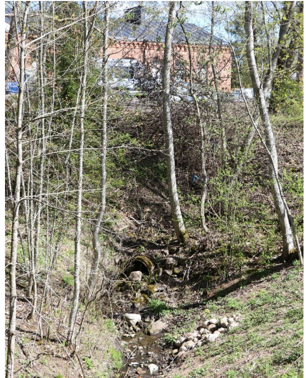
Kuva 23. Näkymä suunnittelualueeseen kuuluvalla lähivirkistysalueelta, jonne ohjautuu laajemman alueen hulevesiä. Putken edustalle on tehty kivistä eroosiosuojausta vuonna 2018.
