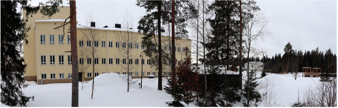
Kuva 8. Näkymä suunnittelualueelle pohjoisesta keväällä 2022. Pioneeripuiston lähivirkistysalueella kulkevan ojan reunalla olevia puita on harvennettu ennen asuntomessuja vuonna 2019.
